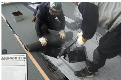
屋根の防水工事
