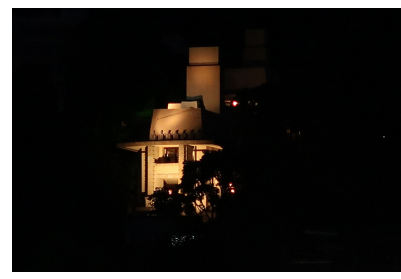
建物のライトアップ用照明設置
