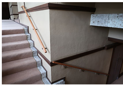
手すりの設置工事
